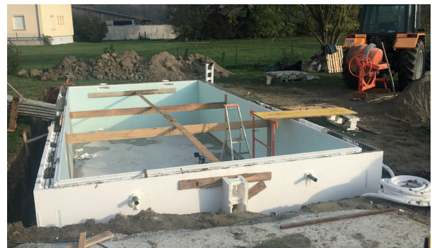
Versteifung der Poolwände vor der Befüllung
